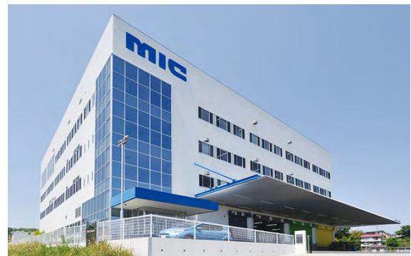
フルサービス部門の旗艦センター「るのパレット」。国内外から年間約300社が視察に訪れる
